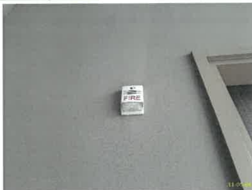
เครื่องแจ้งเหตุด้วยเสียงลำโพงและแสงไฟกระพริบเตือนอัคคีภัย ระบบเตือนอัคคีภัย (ต่อ)
